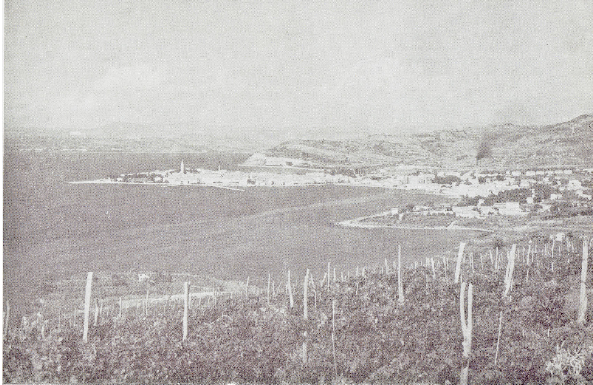
POGLED NA IZOLO
