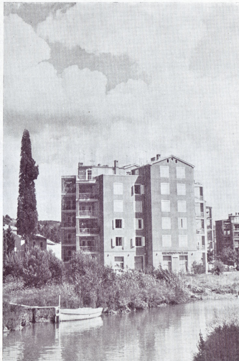
STANOVANJSKI STOLPIČ OB KANALU V LUCIJI
