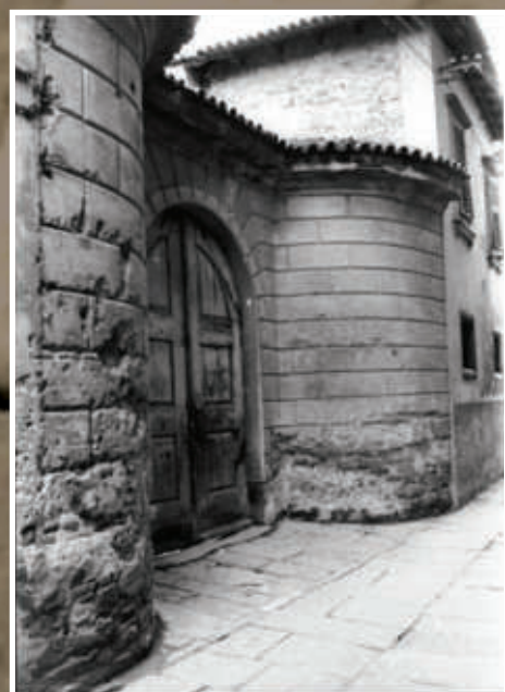
Vhod v nekdanjo koprsko pošto Ingresso al vecchio ufficio postale di Capodistria.
