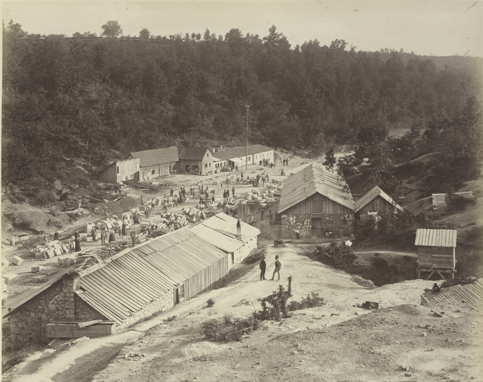
16. Werkplatz beim Tunnel Borutto.
