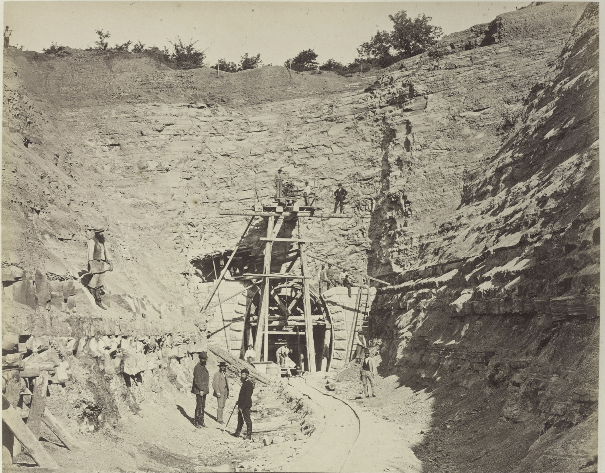
15. Tunnel-Eingang bei Borutto.
