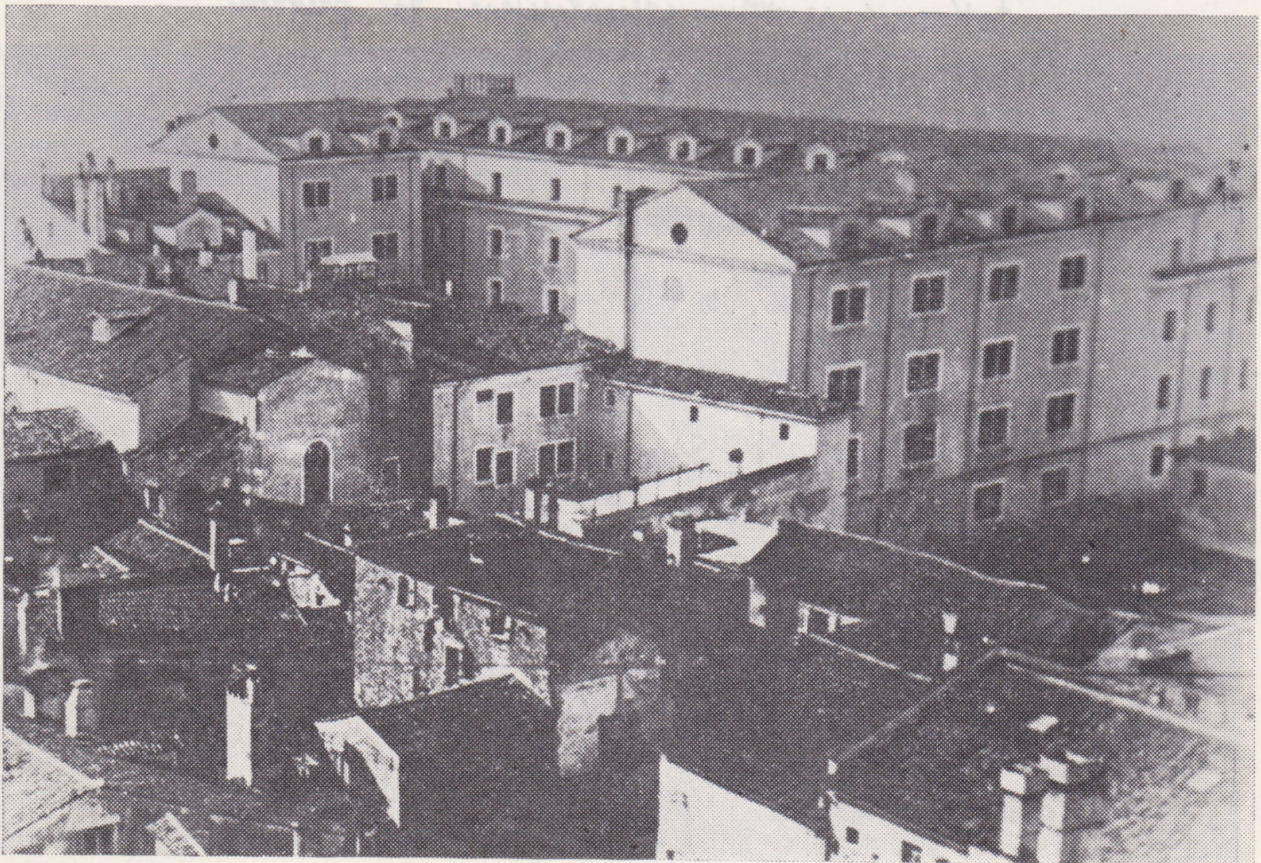
Zapori na prostoru, kjer stoji zdaj šola
