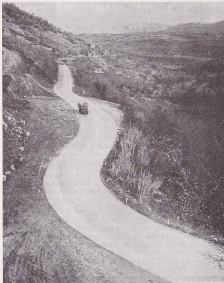
Obnovljena cesta proti Šmarjam
